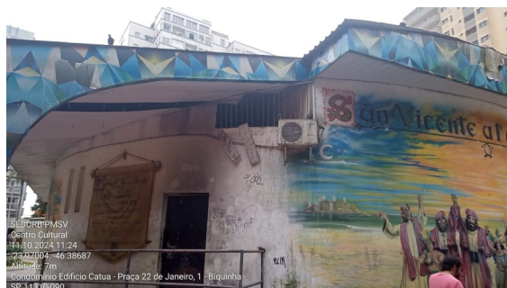
Figura 02- Fachada Lateral (Acesso a rampa)
