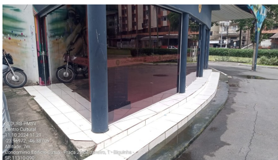
Figura 03- Detalhe do pano de vidro (entrada)
